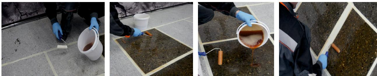
Поверхность должна быть полностью загрунтована. Если поры бетона останутся открытыми – визуально наблюдаются непрокрашенные участки, то воздух, выходящий из них, может вызвать нарушение целостности поверхности свеженанесенного жидкого полимера.
